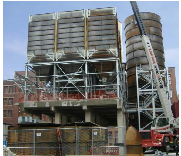
Nach Abschluss der Fundamentarbeiten und der Errichtung des Stahlbaus, kann das letzte Modul an seinen Platz gehoben werden.
